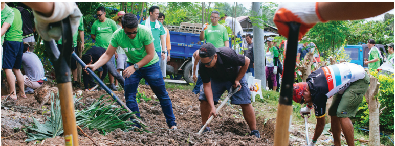
Lexmarkers instala el sistema de captación de aguas pluviales Gawad Kalinga en Cebú, Filipinas
