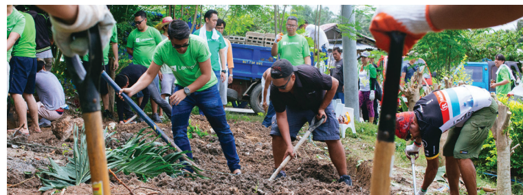
Lexmarkers installiert das Gawad-Kalinga-Regenwasserauffangsystem in Cebu, Philippinen
