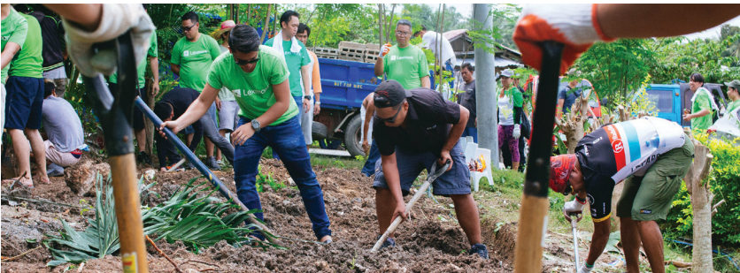
Lexmarkers instalando o sistema de captação de água da chuva Gawad Kalinga em Cebu, Filipinas
